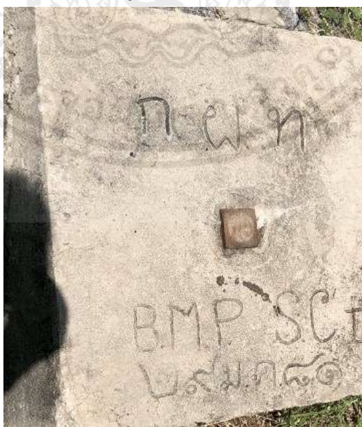
รูปที่ 2. 4 หมุดหลักฐานถาวรจากกรมทหาร B.M.P.SC.II
