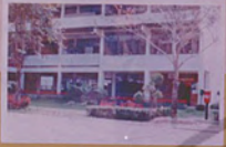
ด้านหน้าอาคาร เป็นอาคาร 2 ชั้น และยังมีลานจอดรถ
