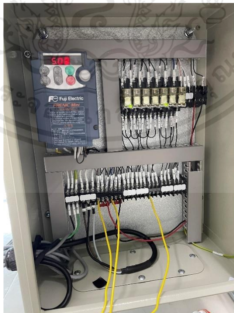
ภาพที่ 3.3 สายการเชื่อมต่อเทอร์มินอลโดยใช้สายไฟเส้นสีเหลือง
