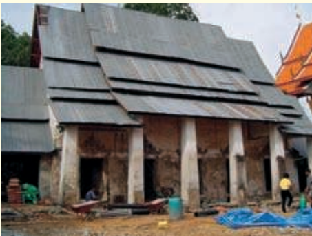
พระอุโบสถวัดชัยพฤกษมาลา กรุงเทพมหานคร ก่อนการตีดยกอาคาร
