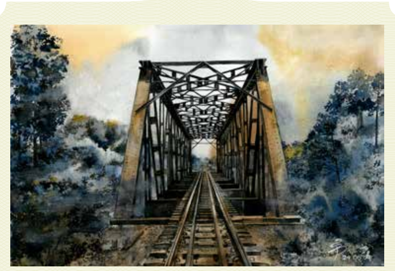
สะพานพระชี • ที่ตั้ง : อยู่ระหว่างสถานีหนองเต็งกับสถานีลำชี ห่างจากสถานีลำชีไปทางทิศตะวันตกราว 2.5 กิโลเมตร • ลักษณะโครงสร้างสะพาน : สะพานโครงขึ้น (Through Truss Bridge) แบบสะพานเดี่ยวรูปสี่เหลี่ยมคางหมู โครงสะพานผลิตโดย บริษัท Les Etablissements Daydé ประเทศฝรั่งเศส • ความยาว : 80 เมตร สร้างข้ามแม่น้ำชี • ปีที่สร้าง : พ.ศ.2468
