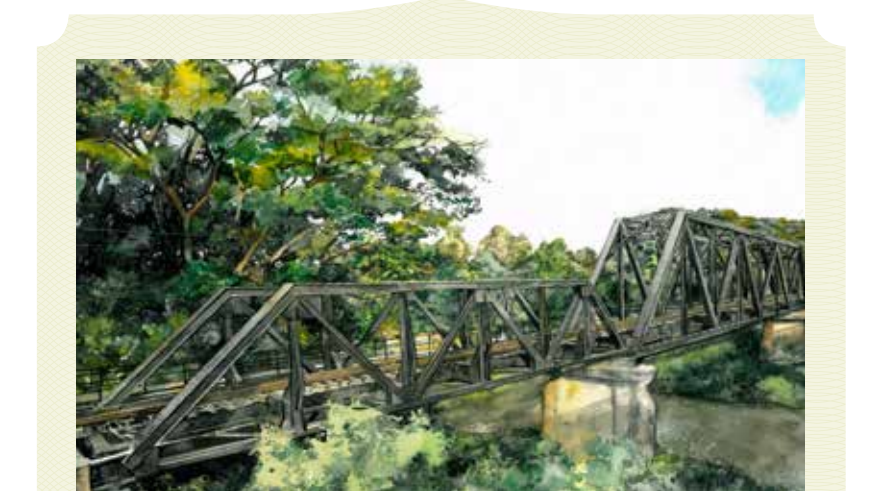
สะพานข้ามแม่น้ำป่าสัก บ้านป่า-บ้านธาดุ ที่ตั้ง : ต.บ้านป่า อ.แก่งคอย จ.สระบุรี อยู่ทางทิศเหนือของสถานีบ้านช่องไทรราว 2 กิโลเมตร ลักษณะโครงสร้างสะพาน : สะพานโครงขึ้น (Through Truss Bridge) รูปสี่เหลี่ยมคางหมู 3 ตอน ตอนที่ 1 และ 3 เป็นสะพานแบบโครงขึ้นแบบครึ่งตัว ตอนที่ 2 ซึ่งข้ามแม่น้ำ เป็นแบบมีเพดานหลังคา โครงสะพานสร้างโดย บริษัท Yokogawa Bridge Works ประเทศญี่ปุ่น ความยาว : ตอนที่ 1 และ 3 ยาวตอนละ 25 เมตร ตอนที่ 2 ยาว 65 เมตร รวมความยาว 115 เมตร สร้างข้ามแม่น้ำป่าสัก ปีที่สร้าง : พ.ศ.2495
