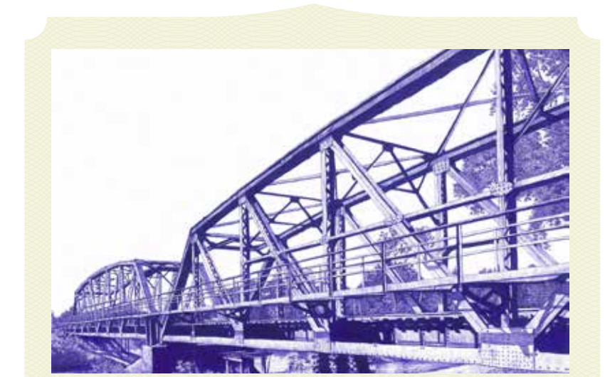
สะพานคลองจันดี หรือสะพานโครงรถไฟ 100 ปี • ที่ตั้ง : ต.จันดี อ.ฉวาง จ.นครศรีธรรมราช อยู่ห่างจากสถานีจันดีไปทางทิศตะวันออกเฉียงใต้ราว 300 เมตร • ลักษณะโครงสร้างสะพาน : สะพานโครงขึ้น (Through Truss Bridge) 2 ตอน แบบโครงหลังคาหลังอูฐ • ความยาว : 100 เมตร • ปีที่สร้าง : พ.ศ.2529
