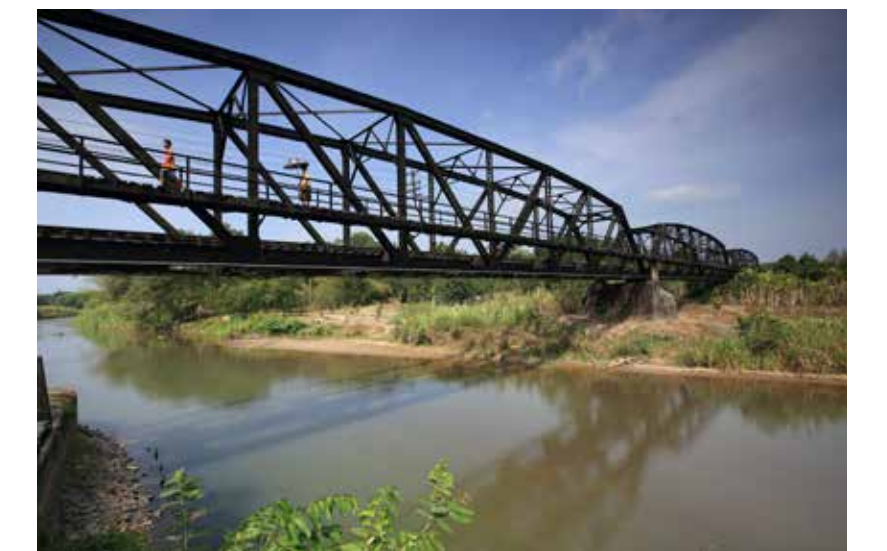
สะพานคลองจันดี หรือสะพานโครงรถไฟ 100 ปี • ที่ตั้ง : ต.จันดี อ.ฉวาง จ.นครศรีธรรมราช อยู่ห่างจากสถานีจันดีไปทางทิศตะวันออกเฉียงใต้ราว 300 เมตร • ลักษณะโครงสร้างสะพาน : สะพานโครงขึ้น (Through Truss Bridge) 2 ตอน แบบโครงหลังคาหลังอูฐ • ความยาว : 100 เมตร • ปีที่สร้าง : พ.ศ.2529
