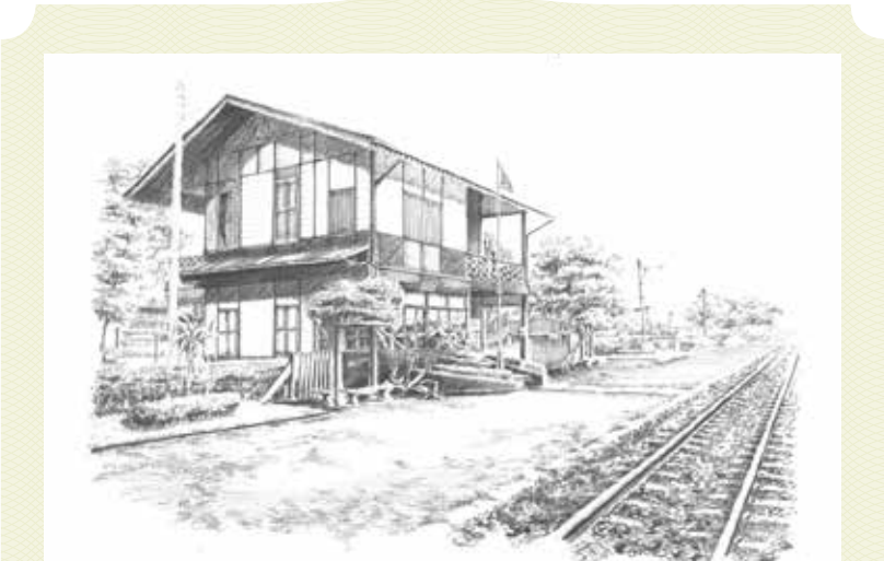
สถานีโคกกรวด ที่ตั้ง : ต.โคกกรวด อ.เมือง จ.นครราชสีมา รูปแบบทางสถาปัตยกรรม : เป็นแบบอาคารไม้สองชั้นเรียบง่าย หลังคาทรงจั่ว ชายคายื่นยาว หลงเหลือองค์ประกอบที่ได้รับอิทธิพลศิลปะยุโรปเพียงแค่ลูกกรงไม้ลายทแยง ประตูหน้าต่างลูกฟัก และคิ้วไม้ตกแต่งหน้าจั่วเป็นวงกลมขนาดด้วยสามเหลี่ยมฐานโค้ง 2 ข้าง แบบสถาปัตยกรรมคลาสสิก (Classicism) ลำดับชั้นของสถานี : สถานีรถไฟชั้น 3 โทร : ไม่มีโทรศัพท์
