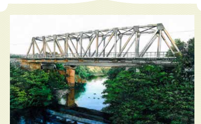
สะพานคลองเพรียว ที่ตั้ง : บ.ตะกวด ต.ปากเพรียว อ.เมือง จ.สระบุรี อยู่ห่างจากสถานีสระบุรีทางด้านทิศตะวันออกเฉียงเหนือราว 1.1 กิโลเมตร ลักษณะโครงสร้างสะพาน : สะพานโครงขึ้น(Through Truss Bridge) ตอนเดียวรูปสี่เหลี่ยมคางหมู ออกแบบโดยกองสำรวจสะพาน ศูนย์สะพาน การรถไฟแห่งประเทศไทย ความยาว : 47.50 เมตร สร้างข้ามคลองเพรียว ที่ไหลลงสู่น้ำป่าสัก ปีที่สร้าง : พ.ศ.2555
