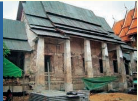
หลังการตีดยกอาคารแล้วเสร็จ
