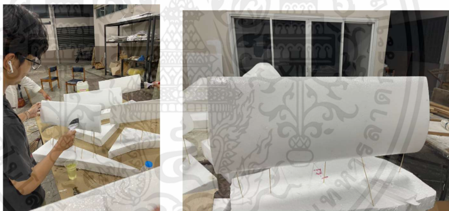
รูปที่ 3.19 การทำ epoxy resin ลงบนโฟมขาว
