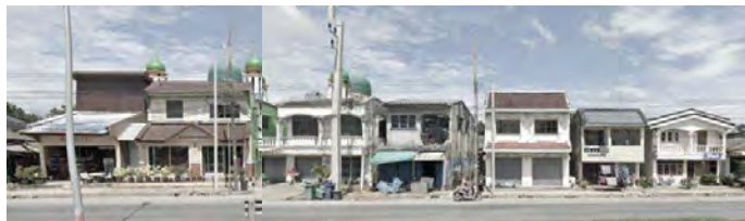
ภาพที่ 1.4 เรือนแถว บริเวณหน้าถนน ของชุมชนบ้านในถุ้ง
