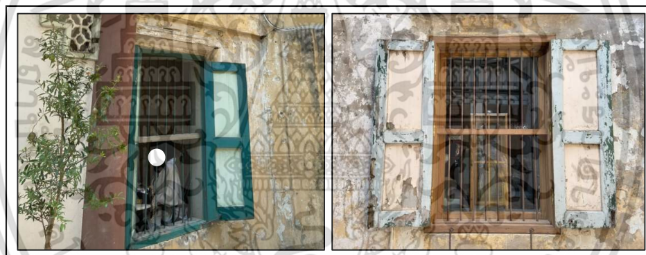
ภาพที่ 4.39 บานหน้าต่างเดิมและวงกบขึ้นเดิม (ซ้าย) บานหน้าต่างเดิมและวงกบขึ้นใหม่ โดยผู้เช่าบ้านเหลียวแลให้ข้อมูลว่าได้นำชิ้นส่วนเดิมที่เสียหาย ถอดออก และนำไปให้ช่างฝีมือทำขึ้นมาใหม่ ในรูปแบบเดิมโดยใช้วัสดุเดิมคือไม้สัก จากนั้นนำมาประกอบใส่ใหม่ในบริเวณที่เสียหาย (ขวา) (ผู้วิจัย)
