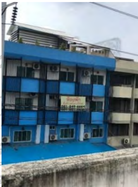
ภาพที่ 2.3 : บางนา – ตราด-กม. 3
