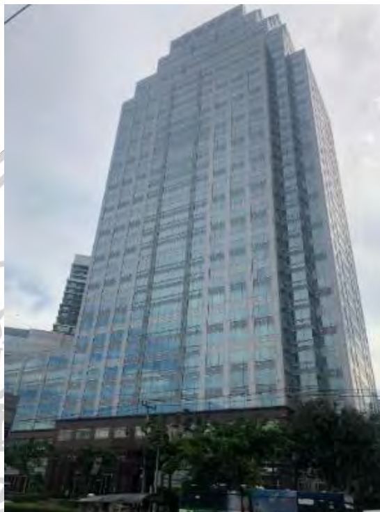
ภาพที่ 2.29 : ตึก ถนนพระราม 4 – อาคาร ริมถนน 1
