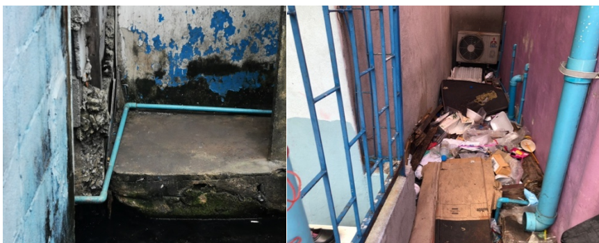
รูปที่ 4.5 ภาพแสดงการต่อท่อประปาภายในชุมชน ที่มา: ผู้วิจัย (2564)
