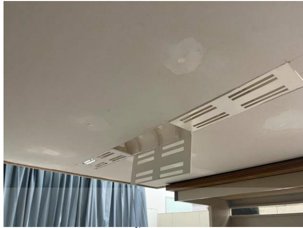
ภาพที่ 4.4 แสดงการติดตั้งระบบท่อนำสายไฟรูปแบบใหม่ ที่มา : ผู้วิจัย (2564)
