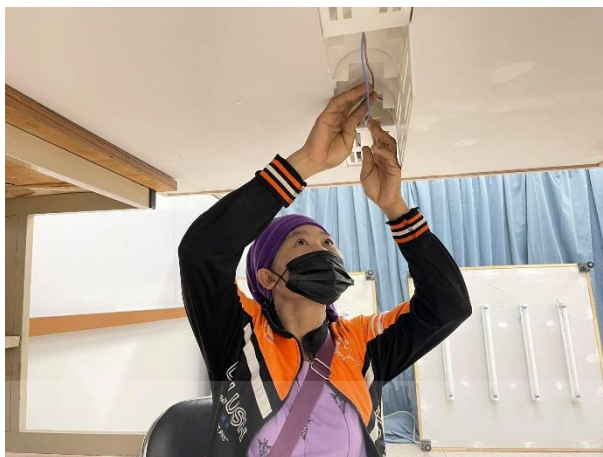
ภาพที่ 4.13 แสดงระหว่างช่างทดลองติดตั้งสายไฟ
