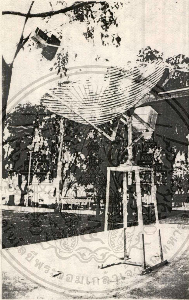
รูปที่ 3.12 แสดงรูปถ่ายของจานสายอากาศที่สร้างขึ้น
