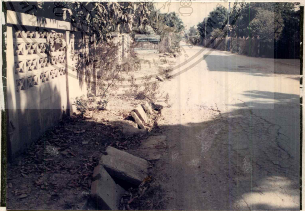
แนวทอระบายน้ำและสภาพผิวจราจรภายในชุมชน
