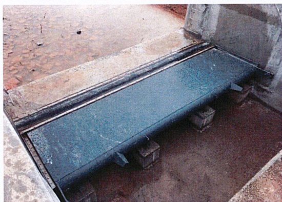
ภาพที่ 4.1 การสอบเทียบจุดสูงสุดและจุดต่ำสุดของฝายพับ
