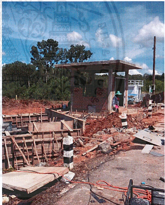
ภาพที่ 1.3 อาคารควบคุมประตูระบายน้ำขณะก่อสร้างและก่อสร้างแล้วเสร็จ
