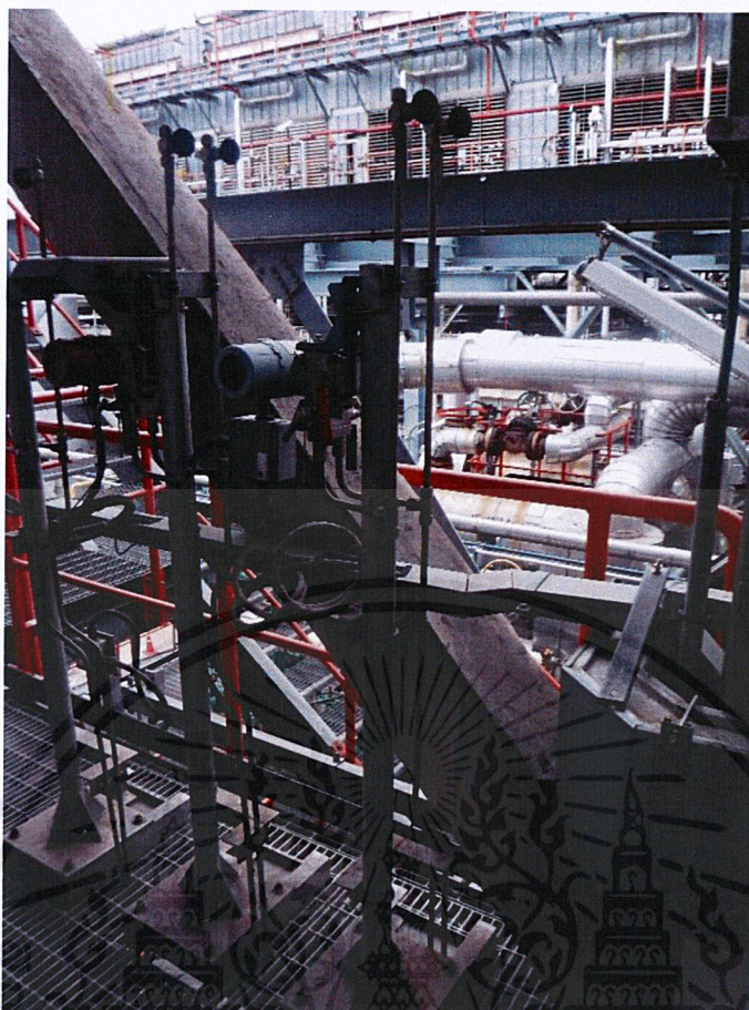
รูปที่ 3.69 แสดงการต่อ Tube เข้ามาที่ Flow Transmitter
