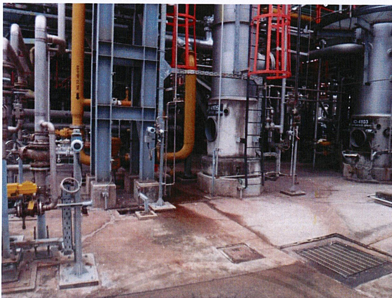
รูปที่ 3.63 แสดงการติดตั้งของ Transmitter แบบ 2”Pipe mounting
