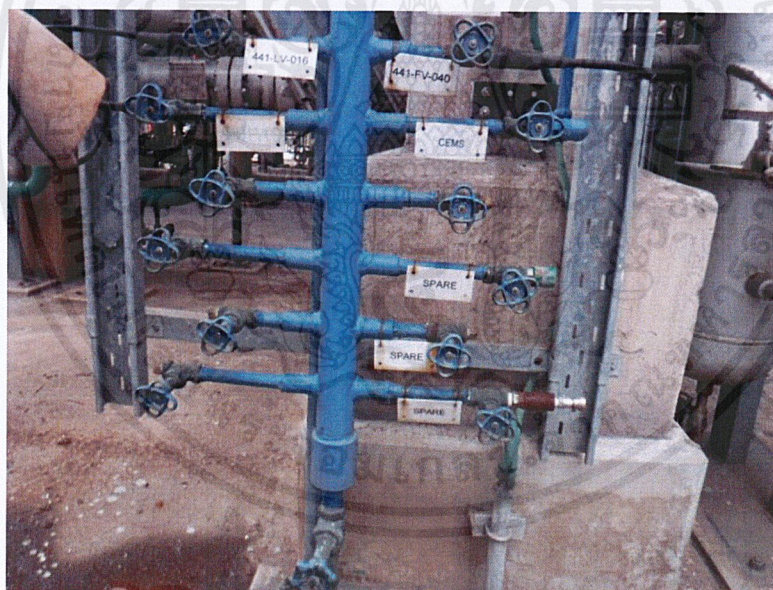
รูปที่ 3.64 แสดง Instrument Air ที่เป็น Spare
