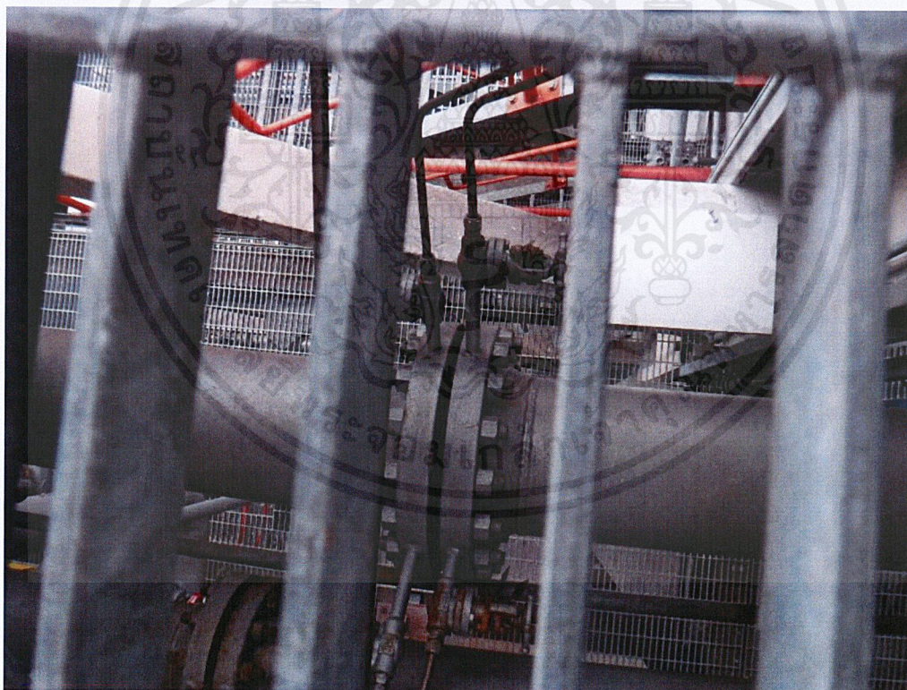
รูปที่ 3.68 แสดงการต่อ Tube ออกจาก Process Line ของ Flow Element
