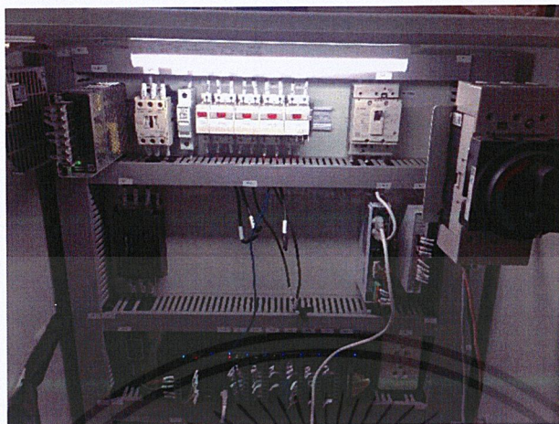
รูปที่ 3.15 การเดินสายไฟบนบอร์ดภายในตู้ควบคุม (Panel wiring)
