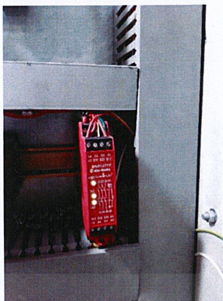
(ข) การแสดงสถานะการทำงานของเซฟตี้โมดูลรุ่น MSR127TP
