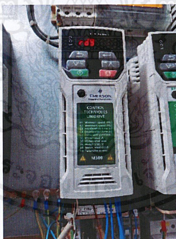
รูปที่ 2.12 มอเตอร์ไดรฟ์รุ่น Unidrive M 300
