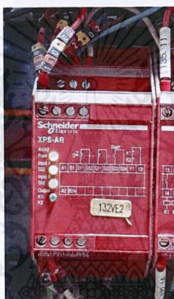
(ค) การแสดงสถานะการทำงานของเซฟตี้โมดูลรุ่น AP-3440
