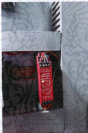
(ข) การแสดงสถานะการทำงานของเซฟตี้โมดูลรุ่น MSR127TP
