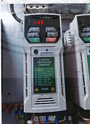
รูปที่ 4.7 มอเตอร์ไคโรฟรุ่น Unidrive M 300 ในตู้ไฟฟ้าโพส CX1
