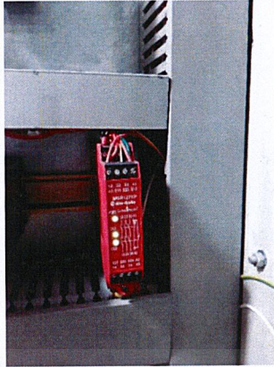
รูปที่ 4.2 เซฟตี้โมดูลรุ่น MSR127TP ในตู้ไฟฟ้าเครื่องจักร BMTc
