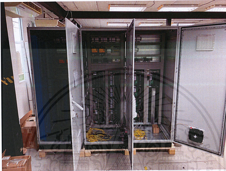
รูปที่ 3.21 การติดตั้งอุปกรณ์และสายไฟภายในตู้
