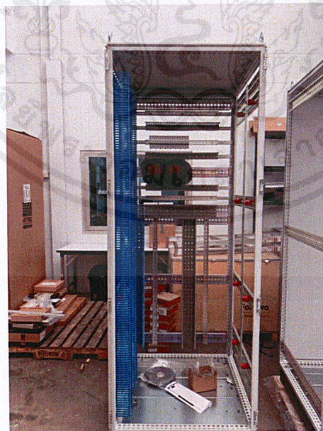
รูปที่ 3.20 การติดรางเก็บสายไฟ และรางปีนก
