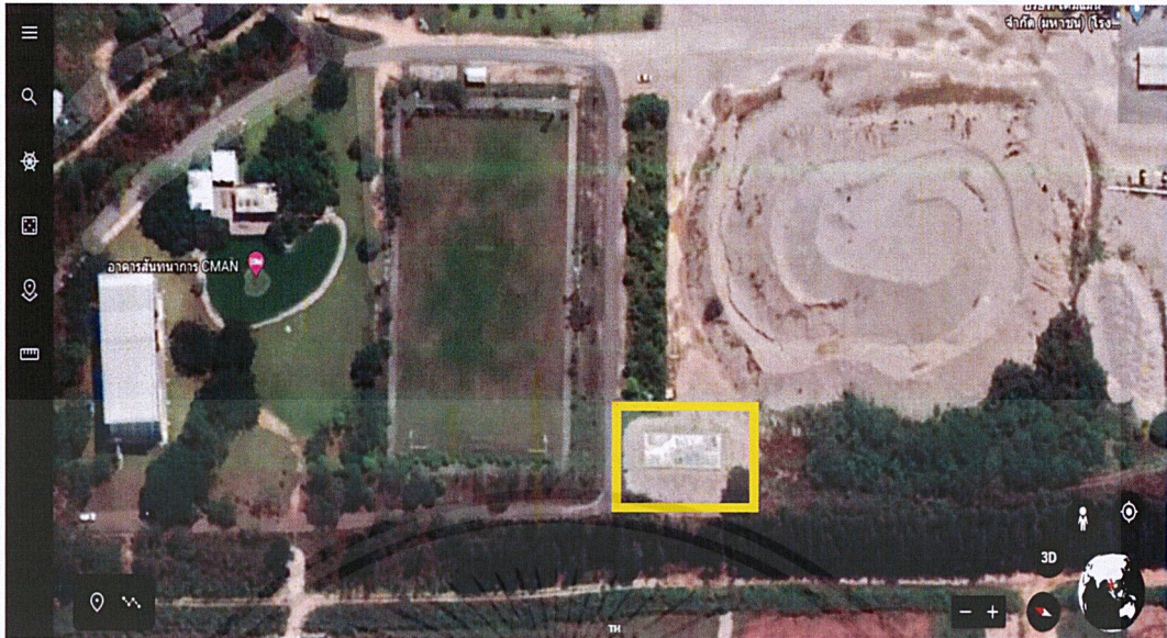
ภาพที่ 3.6 จุดที่มีการติดตั้งถังน้ำ 75Q จำนวน 4 ถัง บริเวณข้างสนามฟุตบอล
