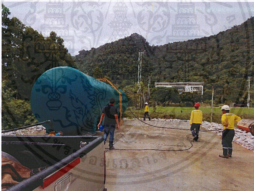
ภาพที่ 3.7 การติดตั้งถังน้ำ 75Q จำนวน 1 ถัง
