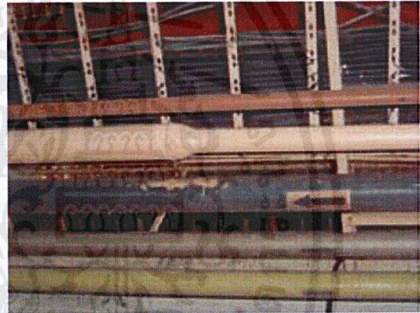
รูปที่ 2.12 การเปลี่ยนทิศทางการไหล และการลดขนาดท่อเมนที่ทำให้เกิดการสูญเสียแรงดัน
