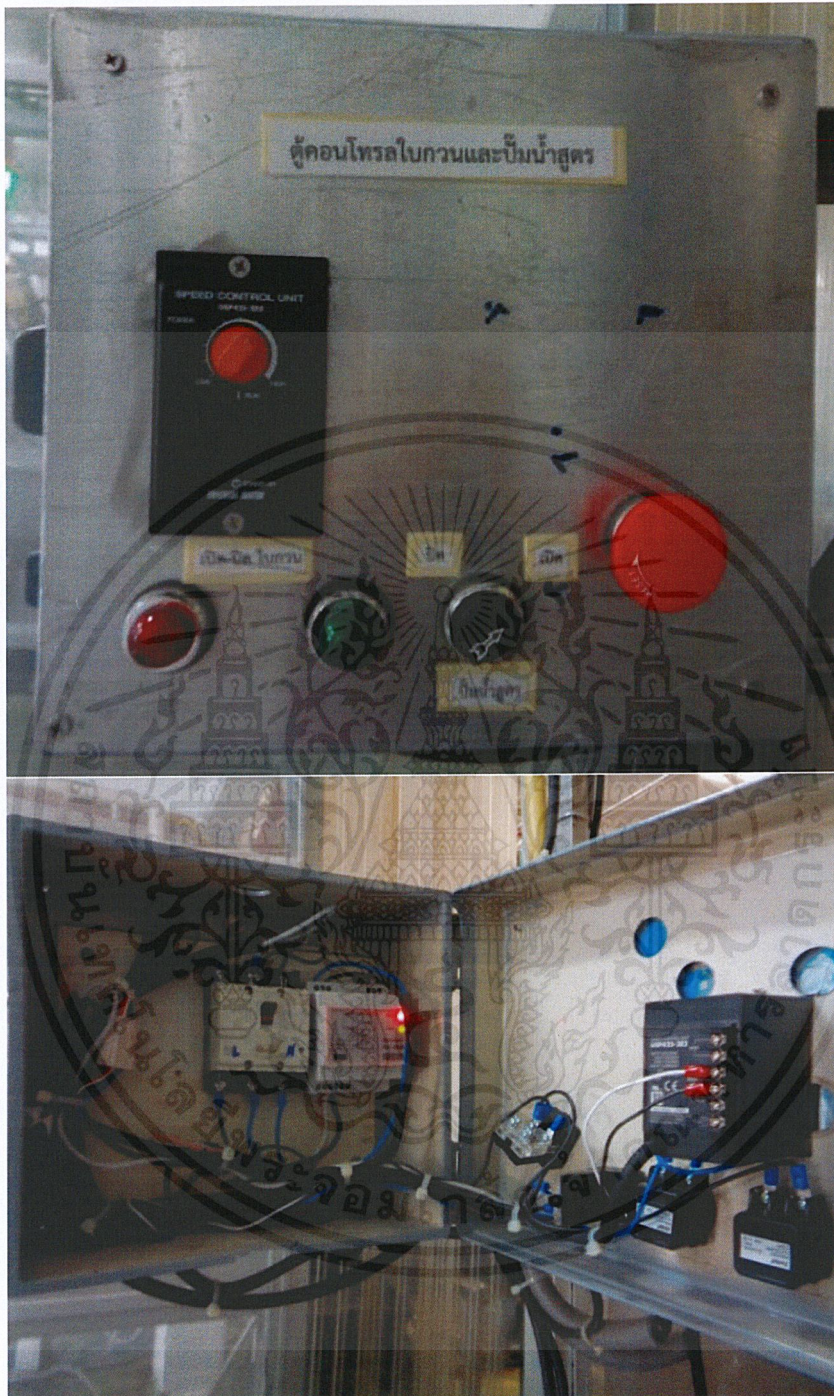
รูปที่ 3.36 ตู้คอนโทรลใบกวนและปั้มน้ำสุตร
