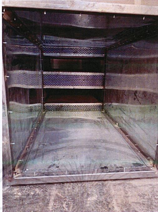
การติดตั้งท่อลมเก็บเสียงในรูปแบบแนวนอน
