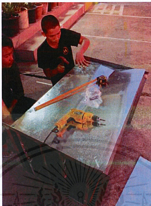
ภาพที่ 3.8 ทำการปิดท่อลมเก็บเสียงทั้ง 4 ด้าน
