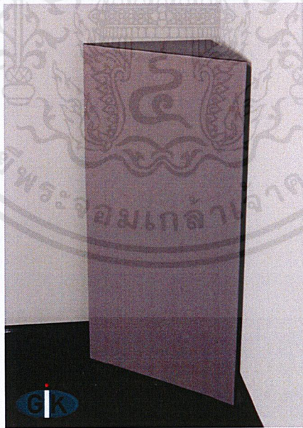
ภาพที่ 3.41 Bass Trap ที่ติดตั้งบริเวณมุมห้อง
