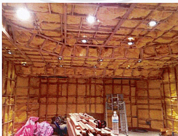
ภาพที่ 2.6 การติดตั้งฉนวนใยแก้วในบริษัท
