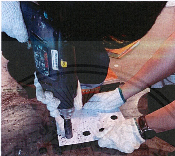
รูปภาพที่ 3.23 การเจาะช่องด้วยการใช้ส่วนพร้อมด้วยดอกเจาะโฮลซอร์ว
