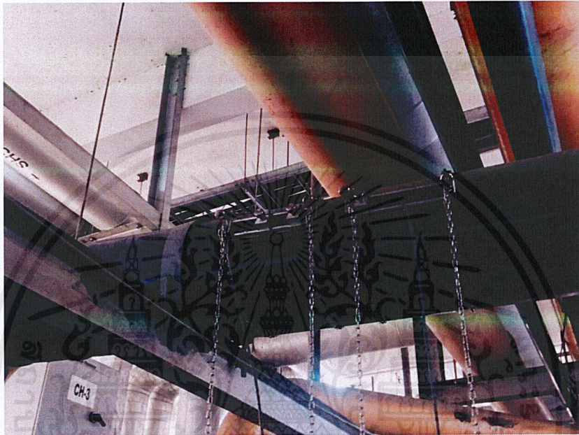
รูปที่ 3.7 การวัดอัตราการไหลน้ำหล่อเย็นด้วยเครื่อง Ultrasonic flow meter
