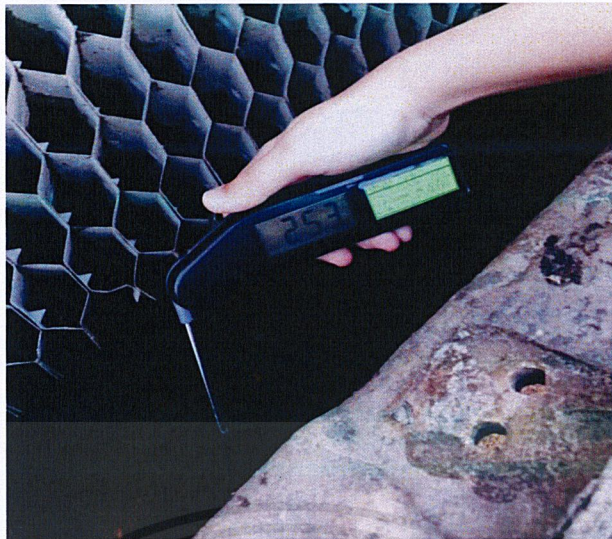
รูปที่ 3.9 การตรวจวัดอุณหภูมิน้ำหล่อเย็นที่เบซินของหอผึ่งเย็นด้วยเครื่อง Thermometer
