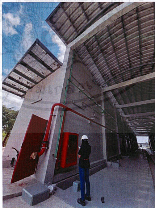
รูปที่ 4.3 ตรวจสอบหน้างานภายในโรงล้างรถไฟฟ้า
