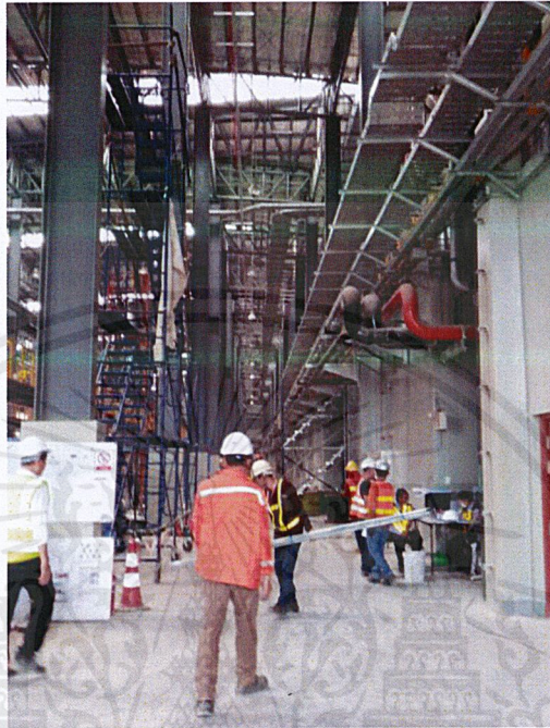
รูปที่ 4.2 ตรวจสอบหน้างานภายในโรงล้างรถไฟฟ้า
