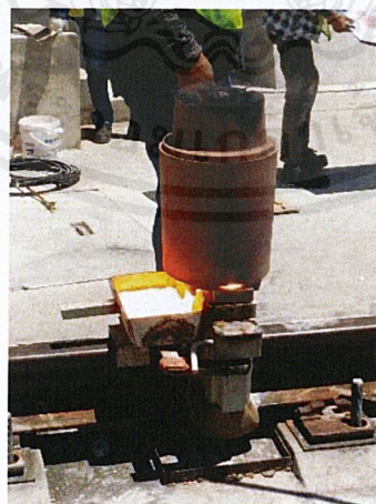
จ) แสดงเหล็กเชื่อมที่ล้นจากแม่พิมพ์
