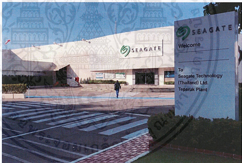
รูปที่ 1.1 โรงงานซีเกต สาขาเทพารักษ์
