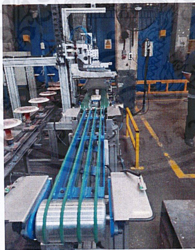
รูปที่ 3.10 สายพานลำเลียงด้าน Unload
