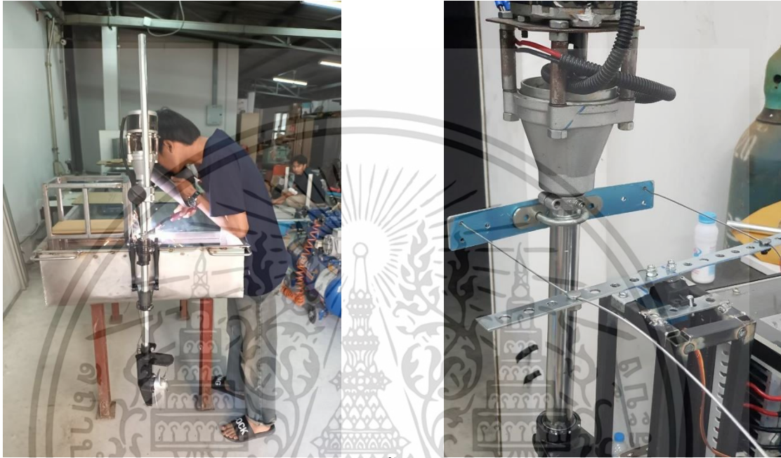
รูปที่ 3.8 ติดตั้งชุดวางเซอร์โว
