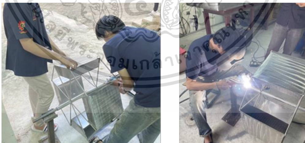
รูปที่ 3.16 ส่วนของใบพัดกังหันน้ำไฟฟ้าที่ใช้บำบัดน้ำเสีย
