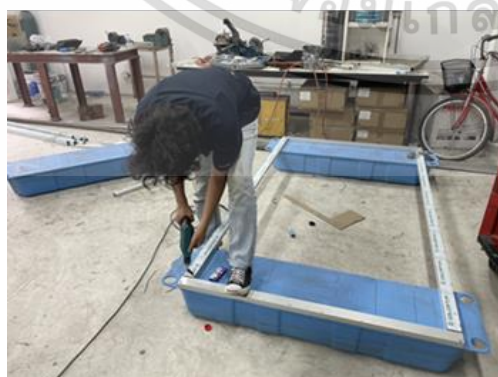
รูปที่ 3.14 ประกอบโครงสร้างฐานกังหันน้ำไฟฟ้า
