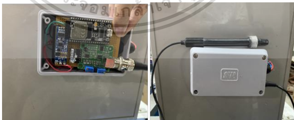
รูปที่ 3.22 ติดตั้งชุดการวัด และเก็บค่าทางไฟฟ้า และค่าความเป็นกรด-ด่าง
