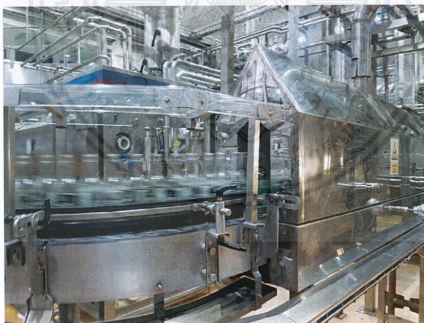
รูปที่ 3.6 การเปิดวาล์ววาล์วไอน้ำน้อยเกินไป
