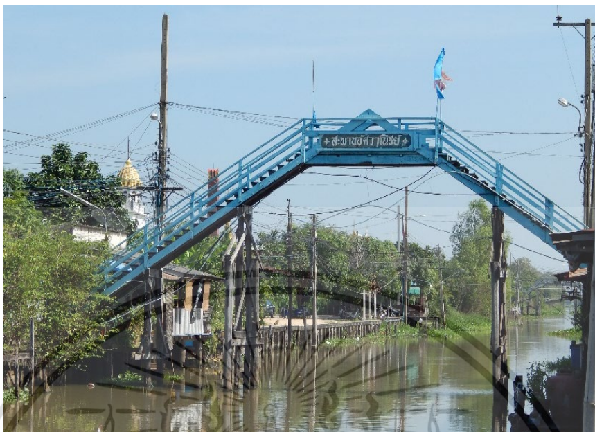
ภาพที่ 4.31 สะพานอัสวานิชย์
