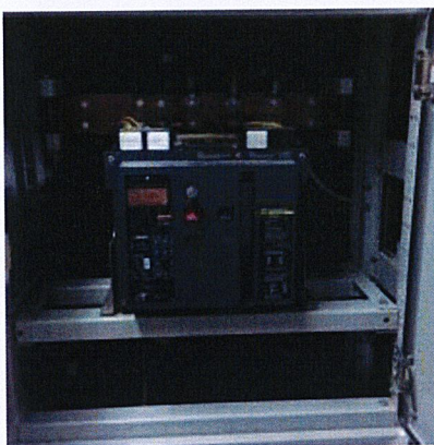
ภาพที่ 2.9 ACB แบบ Fixed Type
