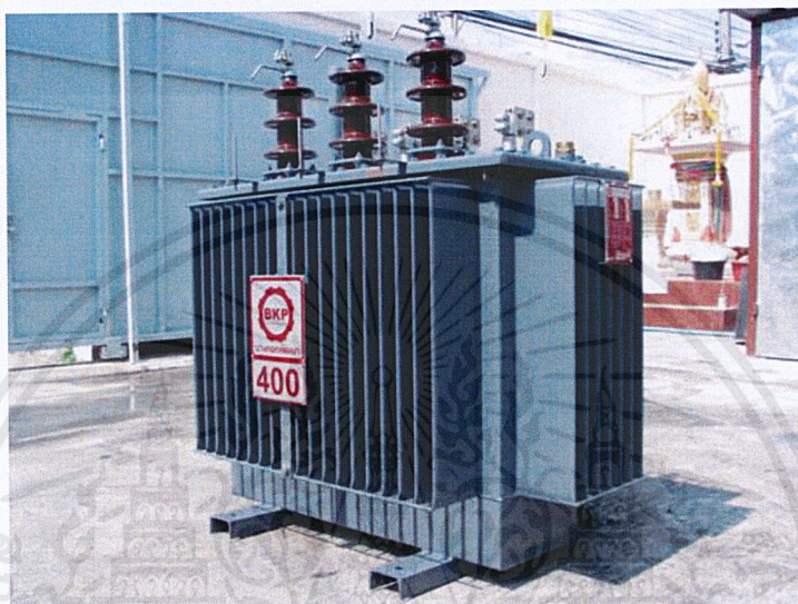
ภาพที่ 2.18 หม้อแปลงไฟฟ้าแบบน้ำมัน (Oil-Type Transformer)
