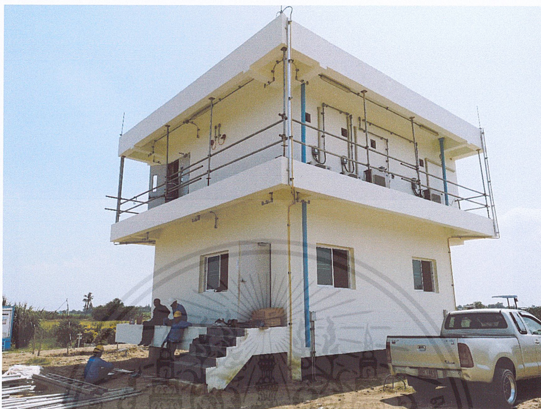
รูปที่ 3.21 อาคารควบคุมสถานี RR1
