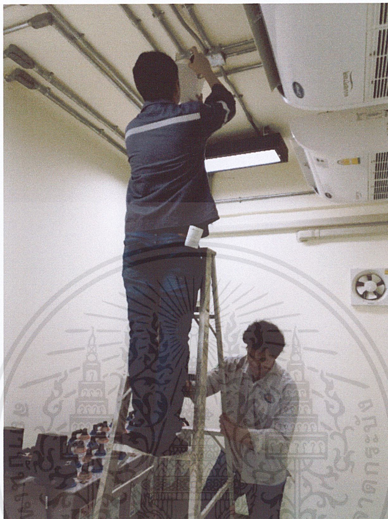
รูปที่ 3.30 ฉีดสเปรย์เพื่อทดสอบอุปกรณ์ตรวจจับควัน
