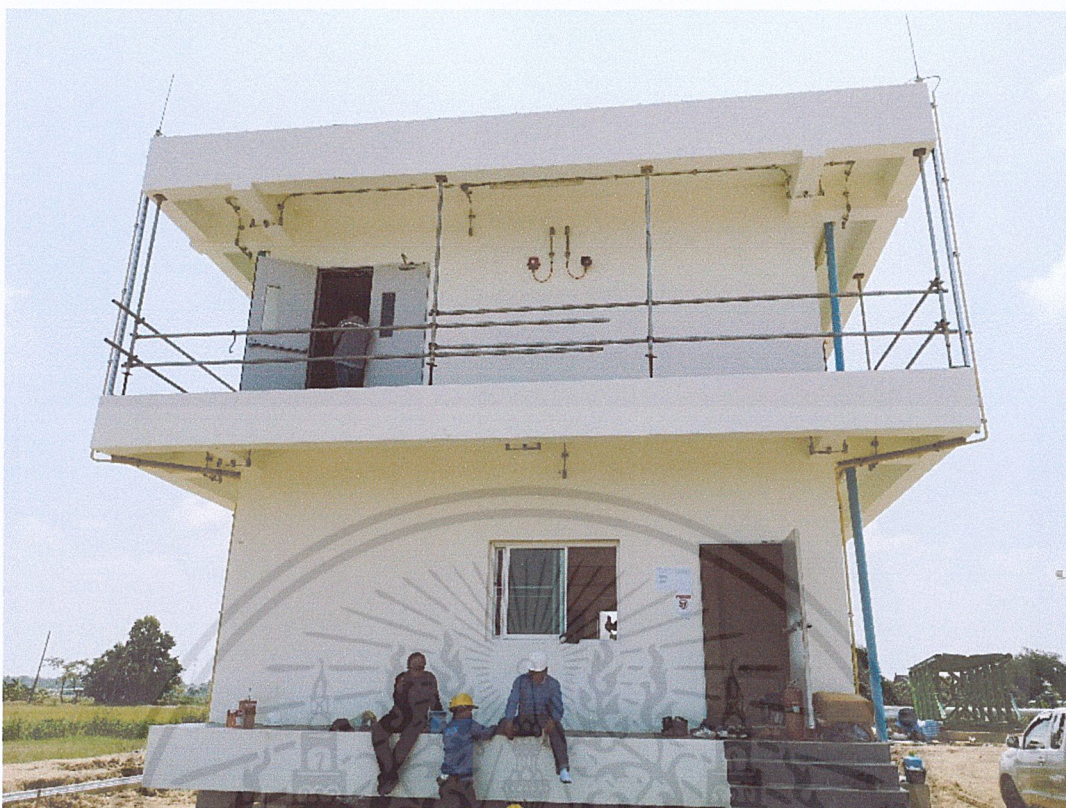
รูปที่ 3.22 Alarm Bell และ Strobe Light ติดตั้งที่อาคารควบคุมชั้น 2
