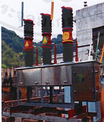
รูปที่ 2.6 Outdoor Circuit Breaker
