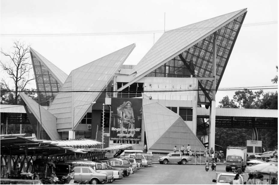
ด่านตรวจคนเข้าเมืองและศุลกากร ช่องเม็ก-วังเต่า ซึ่งมีการก่อสร้างใหม่
