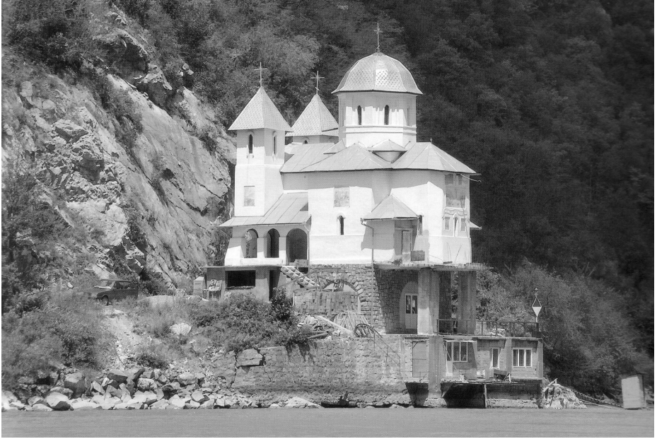
อารามมราโคเนีย (Miraconia Monastery) สร้างอยู่ริมฝั่งแม่น้ำดานูบ เหตุผลที่ต้องสร้างฐานสูงเพราะกระแสน้ำและระดับน้ำขึ้นน้ำลงอันเนื่องมาจากเขื่อนไอรอนเกต (Iron Gate reservoir)
