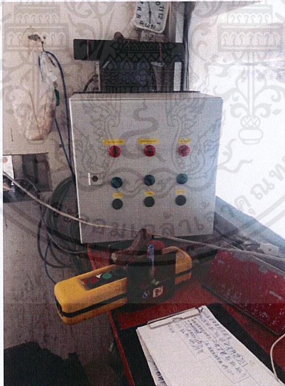
ภาพที่ 3.49 ตู้ควบคุมที่ติดตั้งที่หน้างาน
