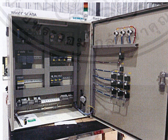
ภาพที่ 4.4 การติดตั้งและต่อสายไฟฟ้าอุปกรณ์ภายในตู้ควบคุม
