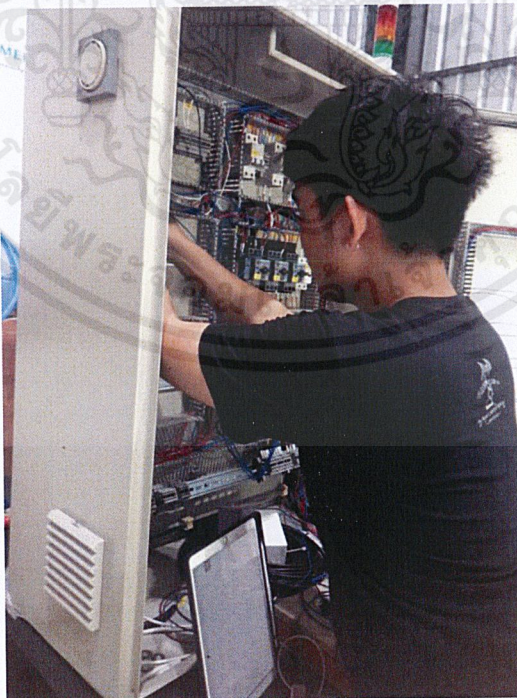
ภาพที่ 3.49 การ Wiring สายภายในตู้ควบคุม
