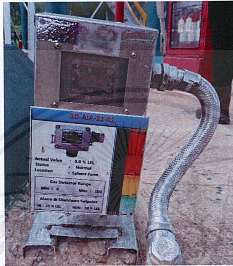
รูปที่ 2.15 เครื่องตรวจวัดแก๊ส (Gas Detector)
