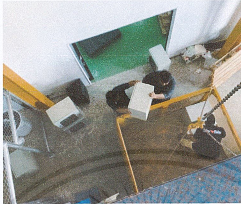
รูปที่ 3.41 ทำการขนย้ายตู้ขึ้นติดตั้งหน้างาน
