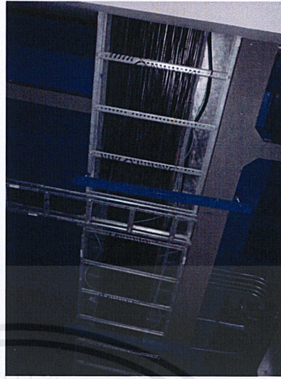
(a) เดินสายไฟจากตู้คอนโทรลไปตามรางท่อ (b) สายไฟต่างๆควรรอยู่ใน tray ตามรูป รูปที่ 3.2 เดินสายไฟใน tray
