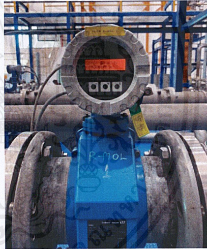
(a) ทำการเข้าสาย Endress + Hauser Promag50 (b) Endress + Hauser Promag50 ขนาด 6 นิ้ว รูปที่ 4.4 ติดตั้ง Endress + Hauser Promag50 ขนาด 6 นิ้ว
