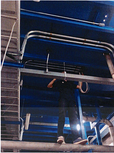
(a) เดินสายไฟจากตู้คอนโทรลไปตามรางท่อ (b) สายไฟต่างๆควรรอยู่ใน tray ตามรูป รูปที่ 3.2 เดินสายไฟใน tray
