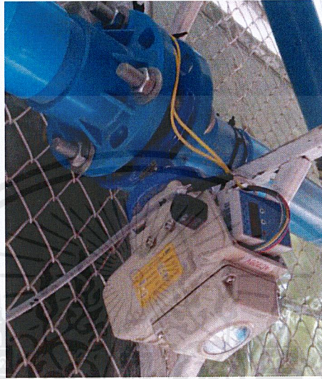
รูปที่ 5.17 แสดงวาล์วปรับอัตราการไหลอากาศ
