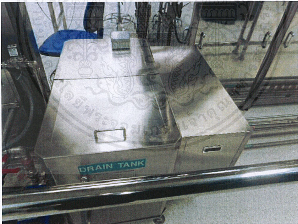
ภาพที่ 2.24 ถังพักสำหรับพักน้ำยาที่เตรนออกจากเครื่องเพื่อให้ความร้อนของน้ำลดลง
