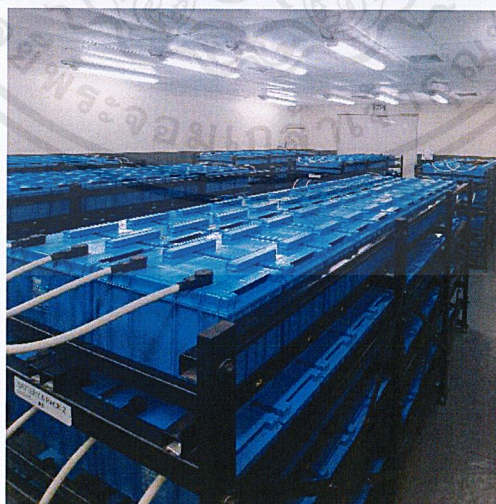
รูปที่ 3.2 ห้องแบตเตอรี่ตะกั่ว-กรด
