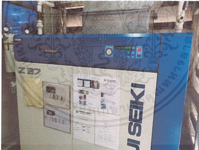
รูปที่ 3.4.4 เครื่องอัดอากาศ (Air Compressor) เครื่องที่ 4 Z375AX 37 kW
