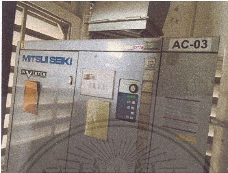
รูปที่ 3.4.3 เครื่องอัดอากาศ (Air Compressor) เครื่องที่ 3 ZV55AS3-R 55 kW
