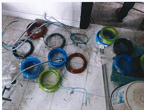
รูปที่ 1-1 สายไฟที่ใช้งานอยู่ตามหน้างาน
