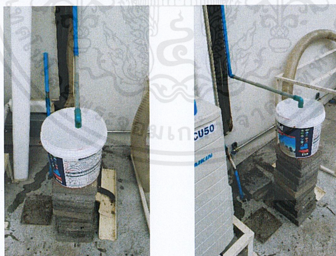
รูปที่ 3.8 การติดตั้งถังวัดปริมาณน้ำ บริเวณท่อน้ำทิ้งของเครื่องปรับอากาศ
